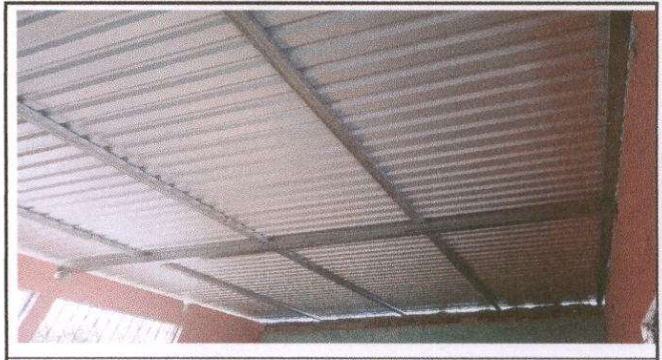
Foto 2: Sustitución de estructura de soporte de madera por metal en el modulo 2 del establecimiento.
